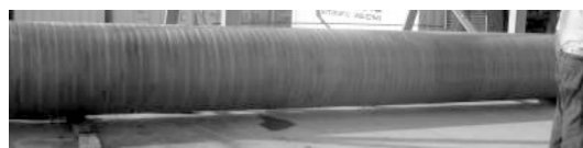
(a) 现场冷弯之前
